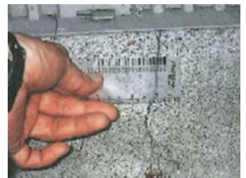
基礎ひび割れの調査
