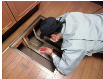
土台・床組・基礎の調査
