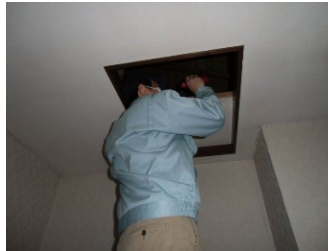
小屋組・梁の調査
